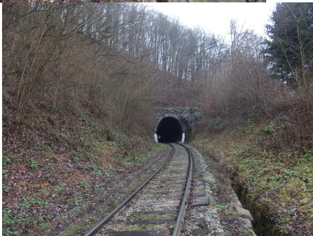
Ochranná palisáda, která bude v rámci sanačních prací nahrazena dynamickou bariérou SO.01 – Pohled na výjezdový portál P2 Doubravského tunelu
