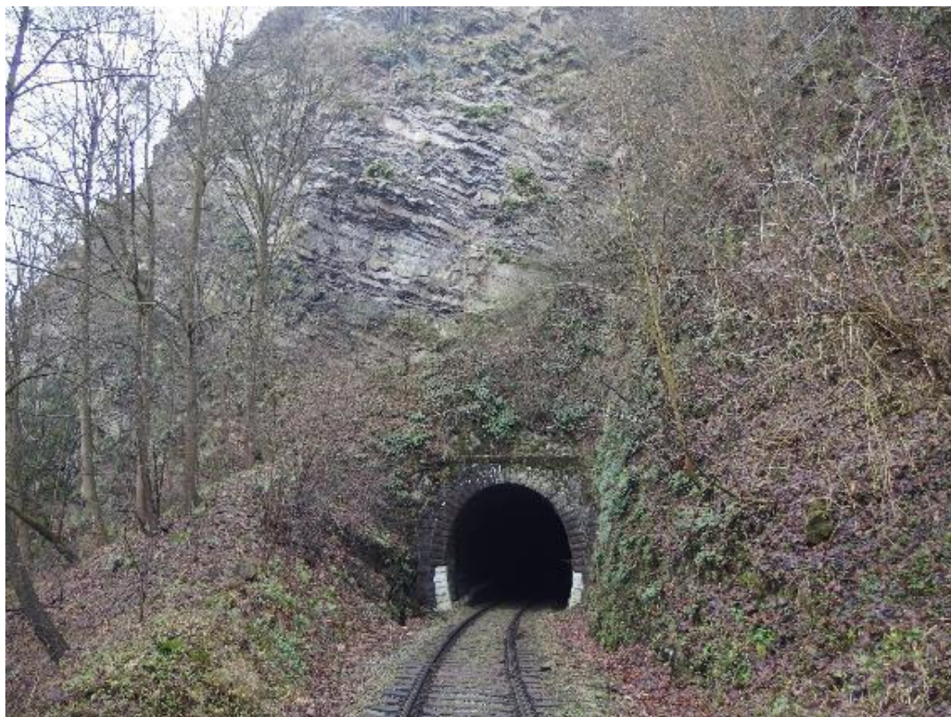
SO.01 - Pohled na vjezdový portál P1, nad kterým budou instalovány dynamické bariéry DB1 a DB2
